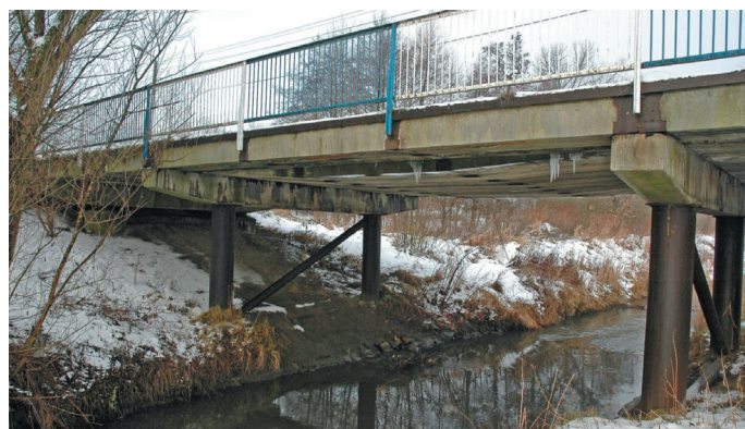
Fot. 1. Widok mostu od strony południowo-wschodniej
