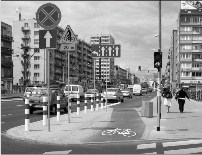
Fot. 5. Prawidłowe rozwiązania kształtują prawidłowe zachowania użytkowników. Dzięki wzorcowemu włączeniu drogi dla rowerów w jezdnię większość rowerzystów kontynuuje podróż ul. Puławską przepisowo. Fot. Tomasz Opach, www.zm.org.pl .
