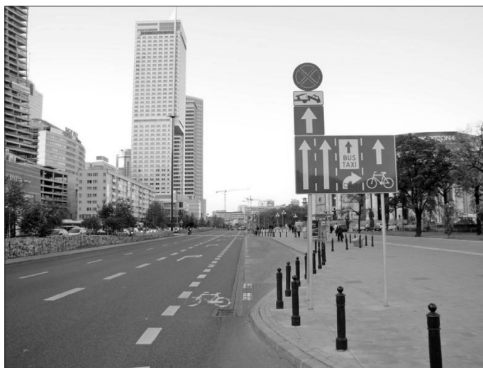
Fot. 2. Pas ruchu dla rowerów na ul. Emilii Plater obok trzech pasów ruchu dla samochodów nie budzi zaufania rowerzystów – dodatkowo jazdę utrudnia rynna odpływowa i wpusty kanalizacji zlokalizowane na pasie ruchu dla rowerów.
