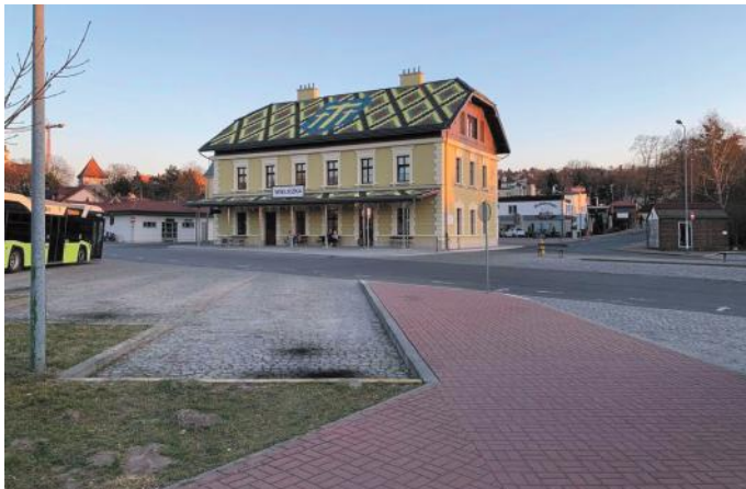
Fot. 1. Dworzec autobusowo-kolejowy, widok od strony peronu kolejowego Źródło: zasoby własne
