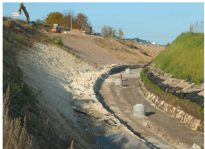
Fot. 2. Głęboki wykop pod torowisko tramwajowe na budowanej linii do Górki Narodowej w Krakowie
