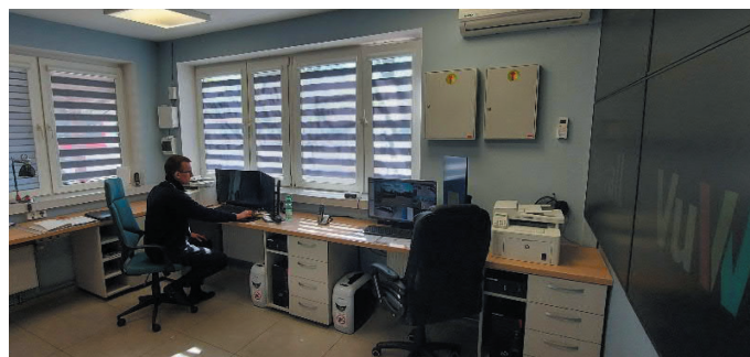
Fot. 1. Centrum Nadzoru Ruchu – stanowisko pracy dyspozytora Źródło: fot. R. Woźniak
