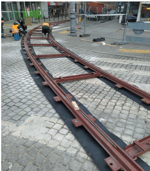
Fot. 3. Montaż łuku nakładkowego Źródło: zdjęcie własne
