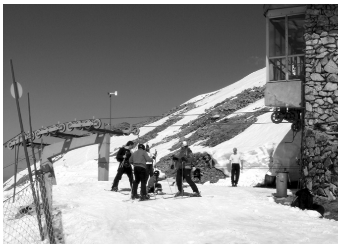
Fot. 2. Górna stacja kolei Goryczkowa – widok od strony zachodniej
